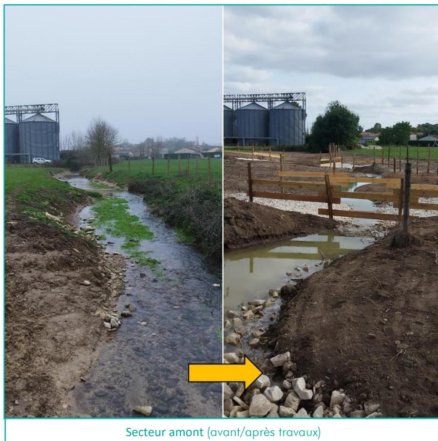
L'ensemble des secteurs ont fait l'objet de mise en place de descente d'abreuvement et de passage à gué. Quelques blocs ont été dispersés dans le nouveau lit et une végétation d'hélophytes et de ligneux a été plantée.
